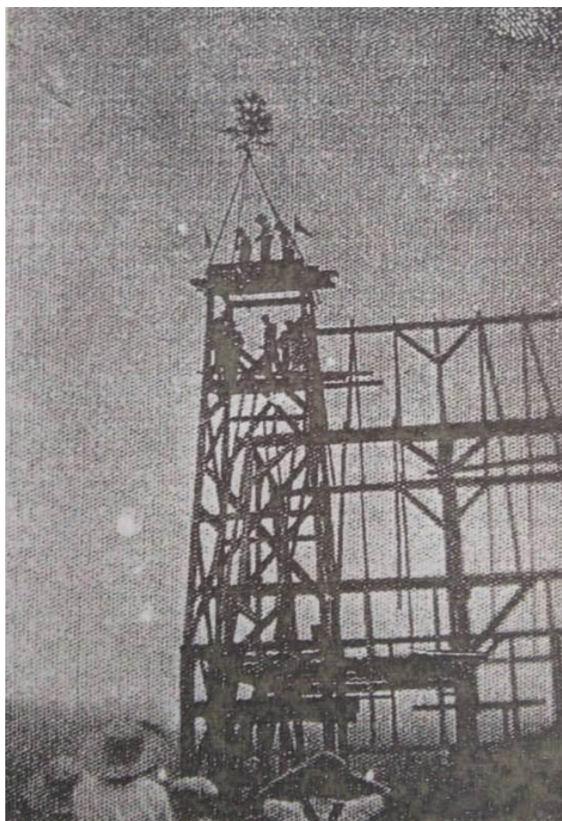
Figura 2 – Detalhe da construção da Igreja enxaimel de Linha Presidente Becker na década de 1930.
