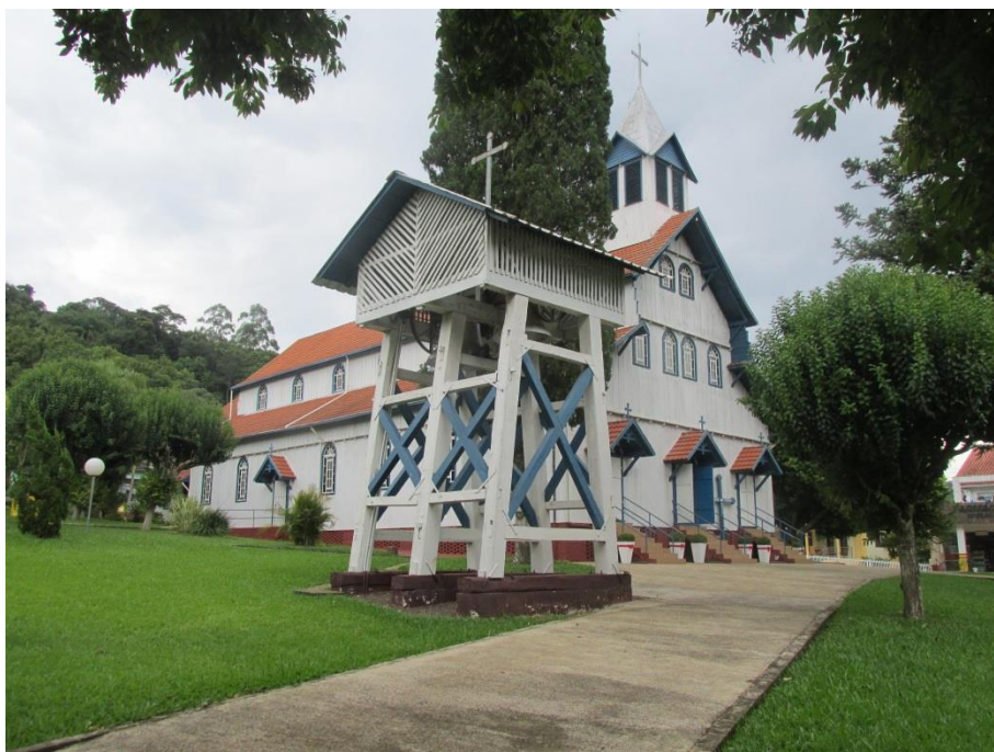
Figura 3 - Igreja de São João do Oeste com campanário enxaimel Fonte: Arquivo do Autor. 2020
