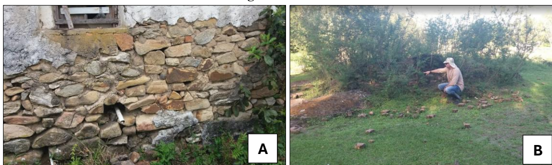
Figura 4: A) Algumas casas sobre taipas de pedra, lascadas em cantaria e embrechadas com pequenos blocos, unidas por barro ligante, estuque e adobe; B) Identificação de uma casa de adobe sobre afloramento rochoso granítico usado como alicerce resistente.
