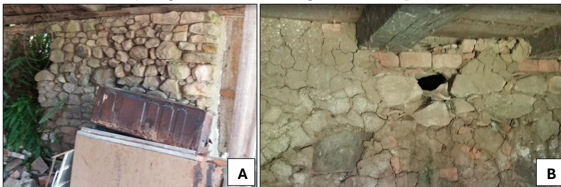
Figura 3: Amuralhamento taipado na técnica da cantaria e embrechamento de blocos. Na direita se observa três tijolos que cobrem uma seteira que é circundada por blocos maiores de rocha.
