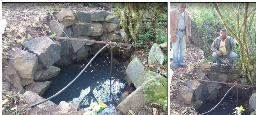
Figura 5: Cacimba e detalhe da cacimba feira em cantaria e embrechamento (sobreposição de blocos em talha - técnica africana) sendo apresentada pelo mestre Griô Jesus Volnei na localidade do Boqueirão
