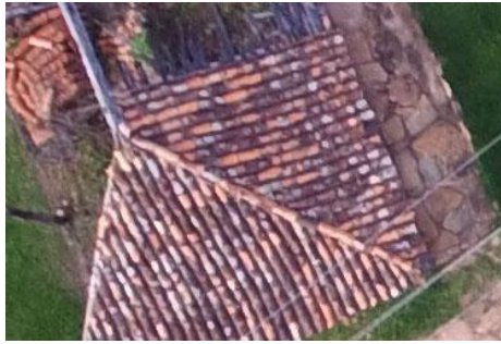
Figura 5. Detalhe da imagem da cobertura ampliada
