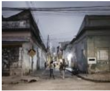
Figura 2 - Os casarões atualmente estão em estado degradado e são habitados por 6 famílias.
