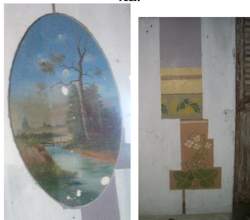
Figura 11 – Detalhe do medalhão e de barrado em estêncil encontrados no Chalé dos Loureiros (prospecção), Penedo-AL.
