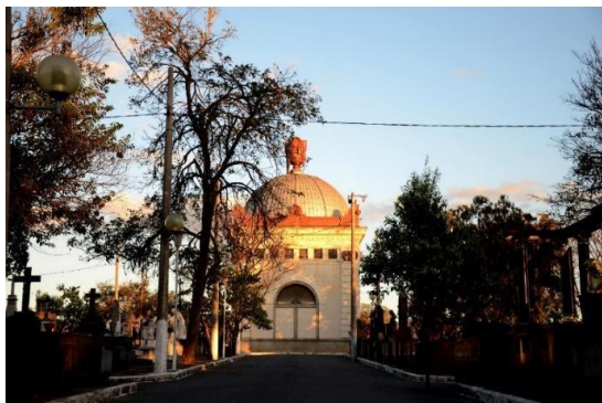
Figura 08: Edifício do Necrotério do Cemitério do Bonfim. Fonte: Izabel Chumbinho, IEPHA, s/d.
