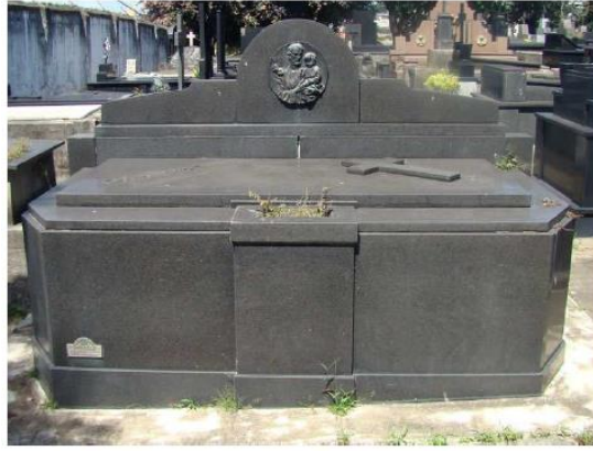
Figura 05: Túmulo da família Bhering. Estrutura em alvenaria, revestimento em granito preto e detalhes em bronze. O túmulo tem uma placa da marmoraria São Geraldo. Fonte: Gerência de Identificação (GID), IEPHA, 2010.
